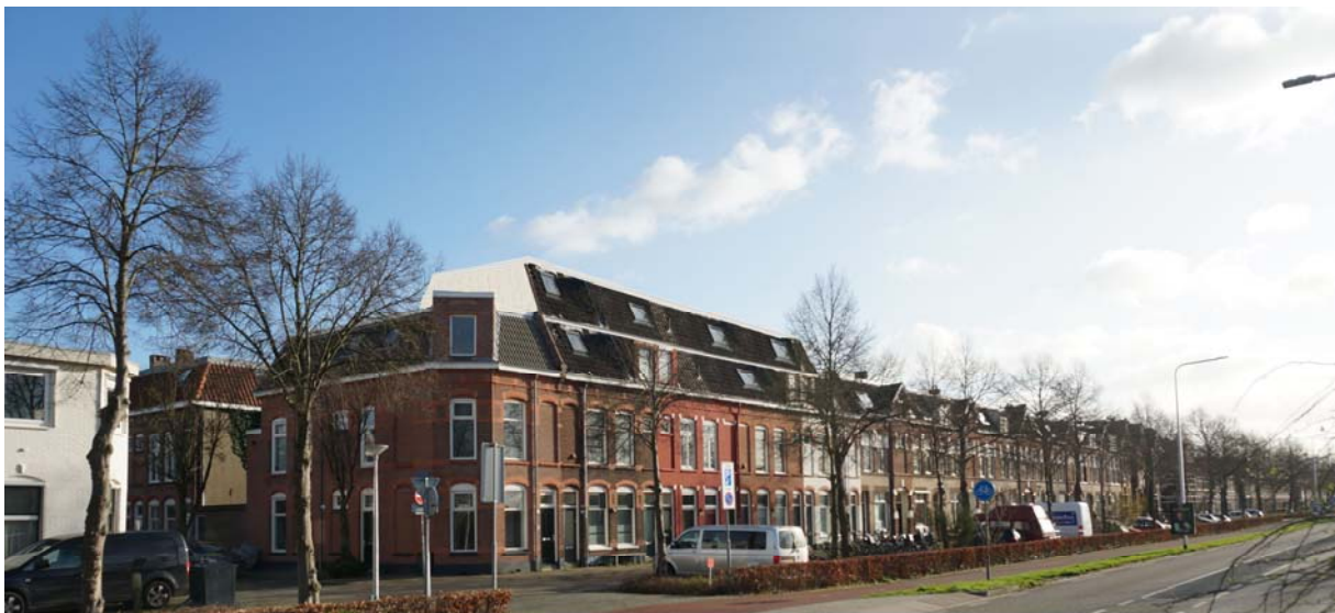
Montagefoto. 4 appartementen op historische woningen Deventerstraatweg
